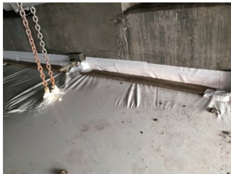
床面養生熱収縮シート 端部処理
