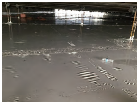
床面養生・熱収縮シート
