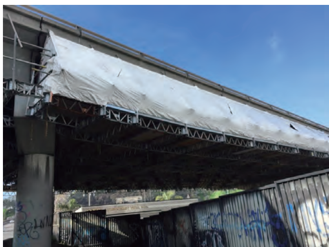
封じ込め（熱収縮シート） 外観朝顔部
