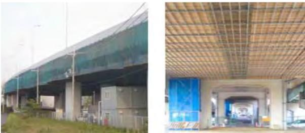
現場ブラスト作業における養生の例（I桁橋）
